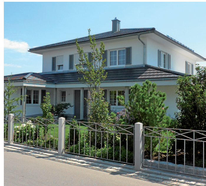
Auch hier zeigte sich die Zimmerei Gay für den Dachstuhl und das Decken des Daches verantwortlich.
